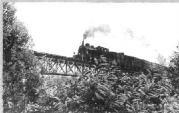
Travessant un dels nombrosos viaductes
