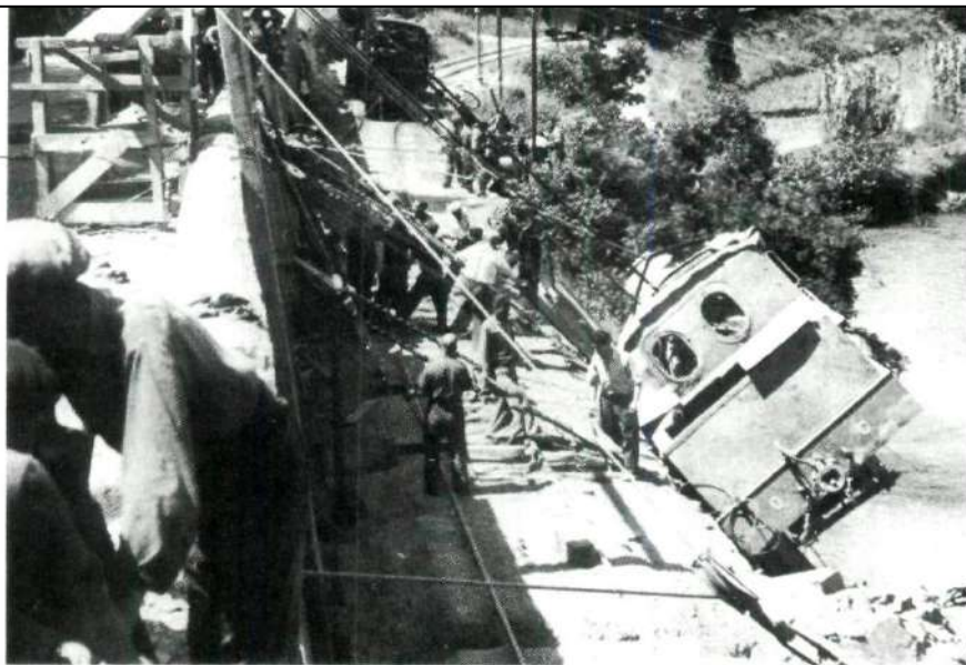
Els treballs per a la recuperació de la màquina del tren d'Olot caiguda al riu van ser molt laboriosos. A sota, els ferroviaris que viatjaven en el comboi descarrilat. El tercer a la dreta és Enric Guasch. Fotos: Crescenti.
