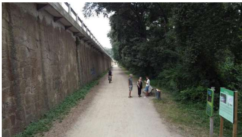
Figura 30 Vista actual del Pas del Gegant, indret on es va produir el descarrilament. Es pot observar el talús que també apareix en les fotografies de l'accident. Font: elaboració pròpia
