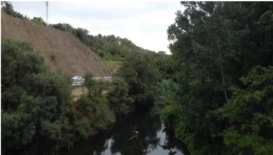
Figura 34. Visió general de la zona del Pas del Gegant. Es pot observar el talús que protegeix la carretera i la via del tren. A baix el pas del riu Ter. A diferència de l'any 1946, el paisatge està molt emboscat. Font: Elaboració pròpia.
