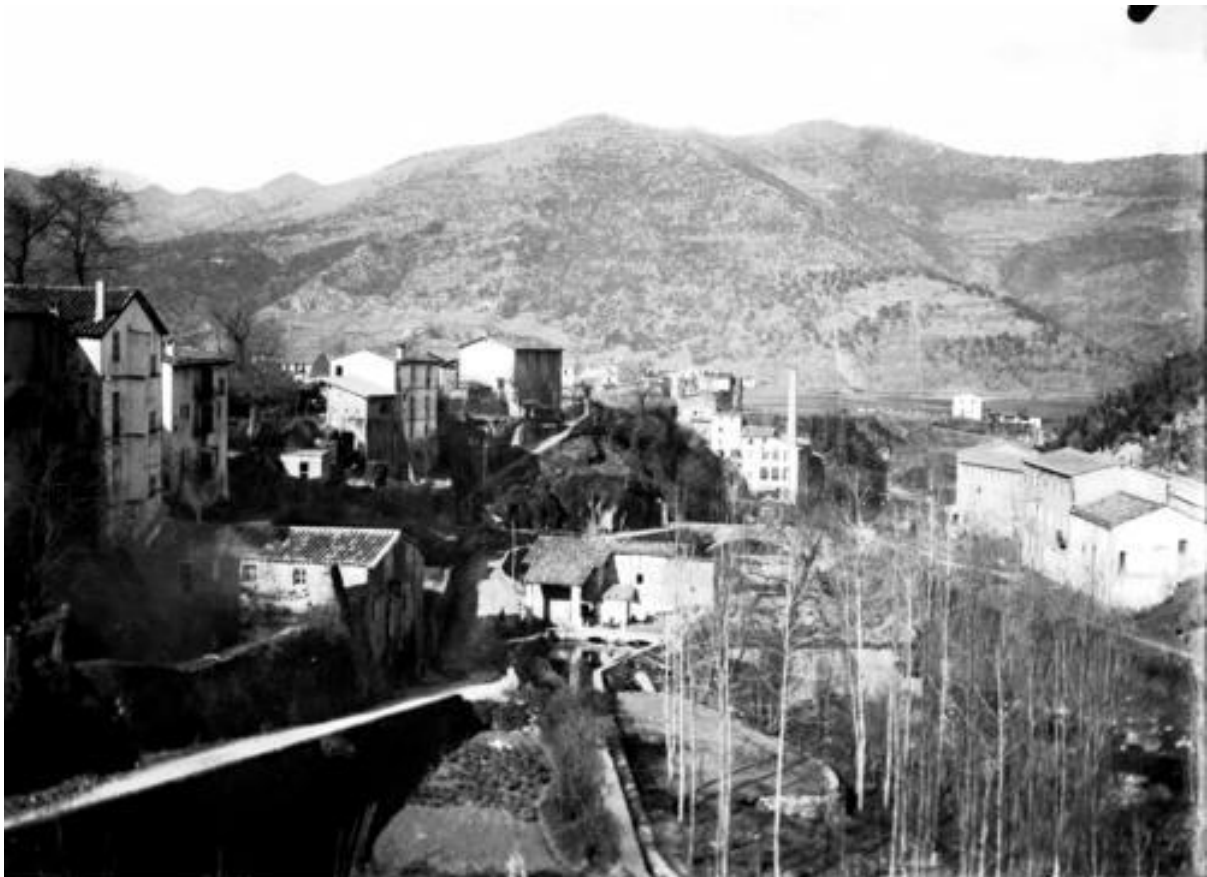
Fig. 39 Vista del riu Fluvià i del poble de la Canya, entre 1912 i 1930, amb la fàbrica de Can Porxas a la dreta. Carme Gotarde. Font: ACGAX, Imatges.
