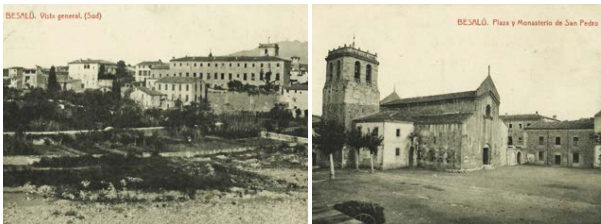
Fig. 25 A l'esquerra, zona d'hortos a prop de Sant Pere, a la dreta, el monestir. Font: https://circusland.org/wp-content/uploads/2019/05/edificio2_2-1.jpg
