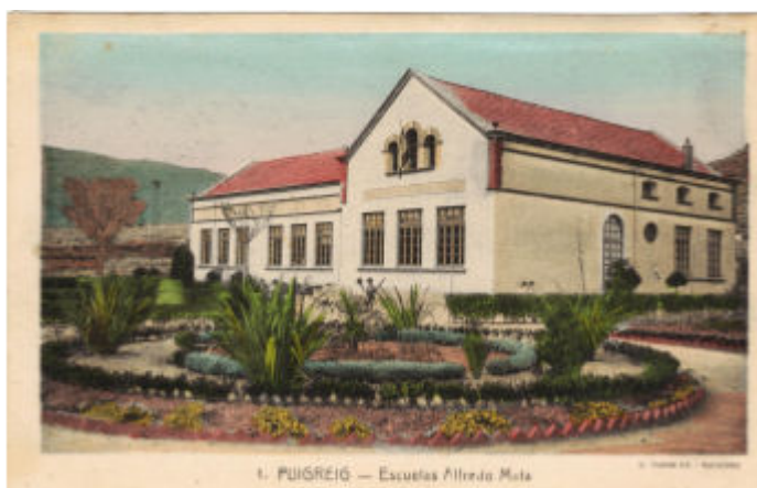
Primer edifici Escola Alfred Mata
