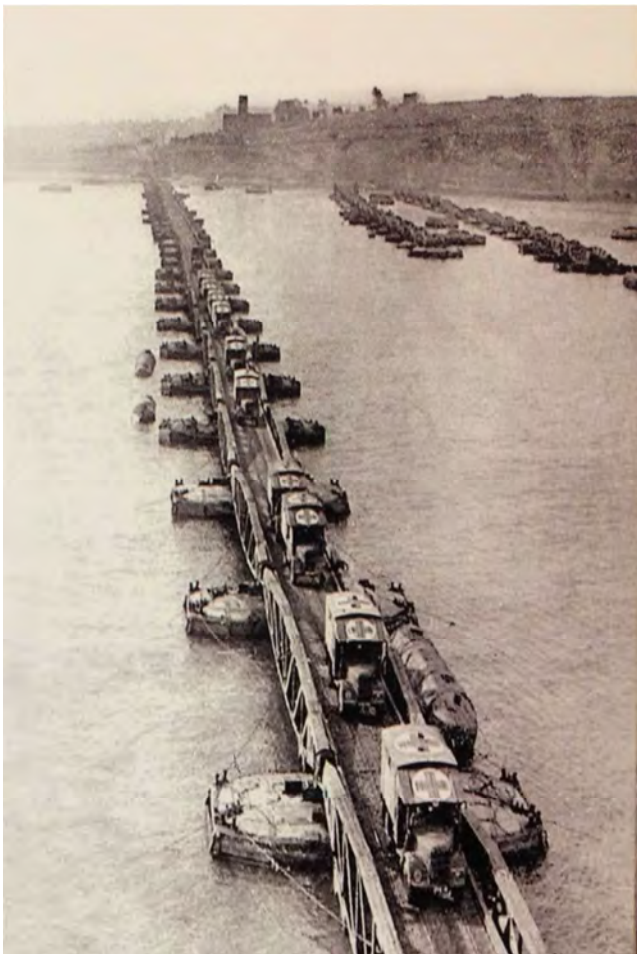
Imatge 54. Carretera flotant formada per trams metàl·lics sostinguts per flotadors "Beetles". 1944
