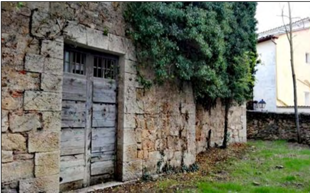
Imatge 7. Estat actual de l'antiga presó de Benavarri
