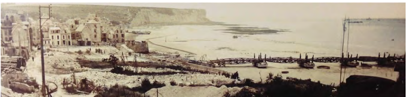
Imatge 51. Carretera flotant del Mulberry B, després del dia D
