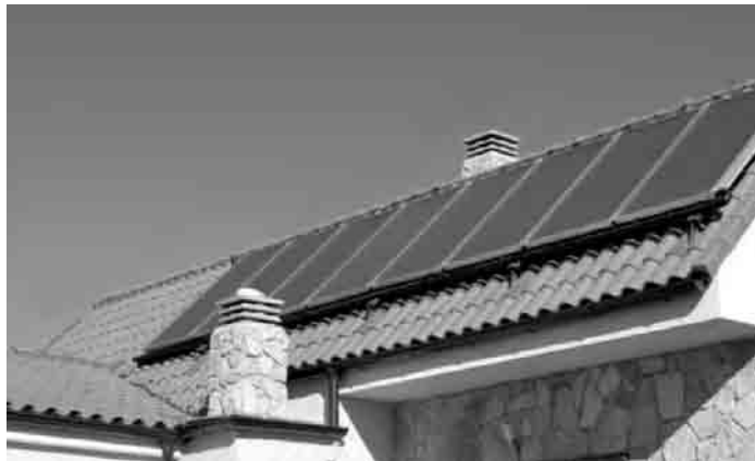
Instal·lació de captadors solars tèrmics en un habitatge. Font: IDAE
