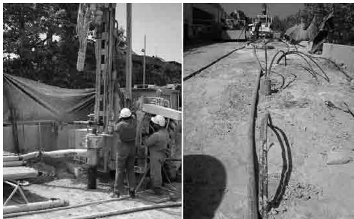
Operacions de les perforacions verticals per una instal·lació geotèrmica (vivendes residencials, Castelldefels). Font: Sol i Clima
