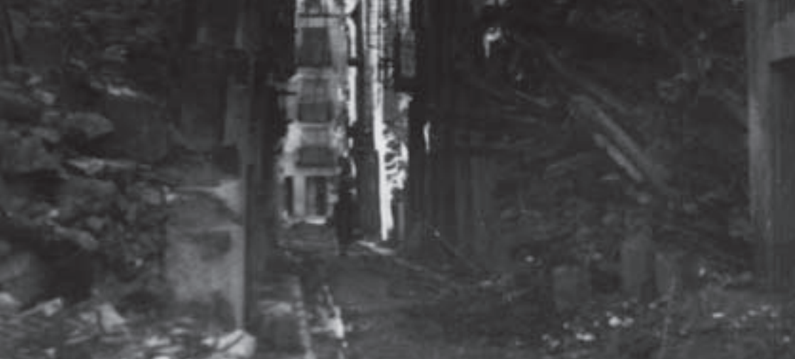
Edificis del carrer Banys de Tortosa, derruïts pels bombardejos de l'exèrcit franquista, durant la Guerra Civil (AHCTE)
