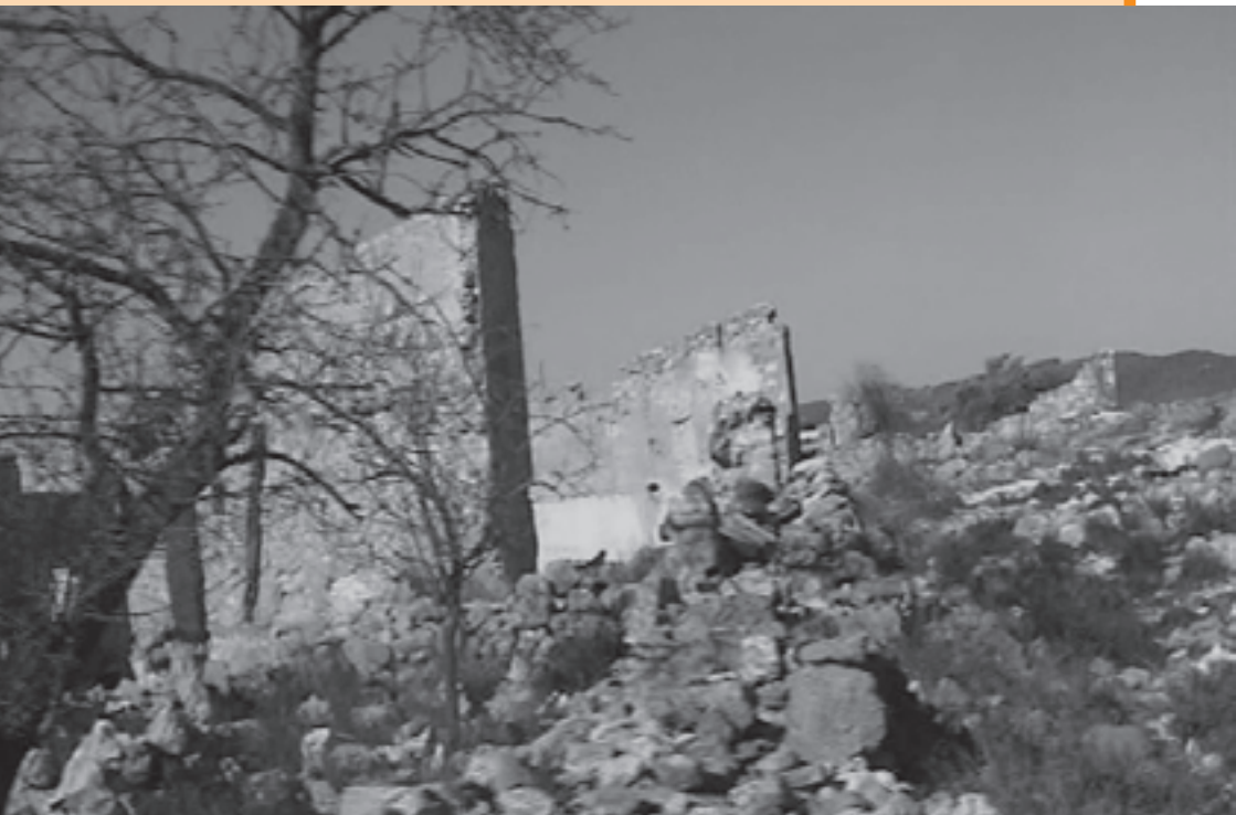
Corbera d'Ebre va quedar derruïda a causa dels bombardejos (A. Roig)
